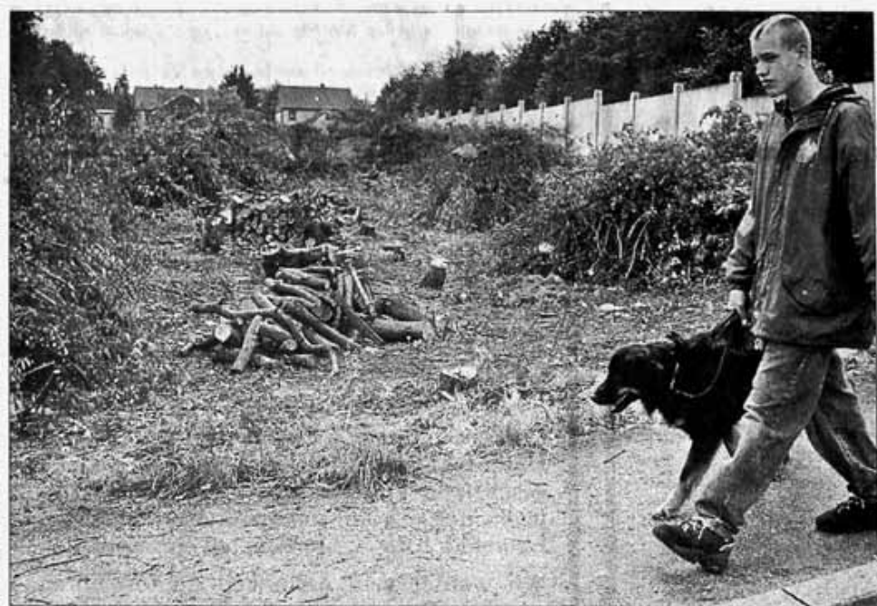
Nur noch Kleinholz: Bäume und Büsche entlang der Lärmschutzwand an der Unistraße wurden mit Kettensägen gekappt. Auf dem Gelände sollen nun Sozialwohnungen entstehen. waz-Bild: Korte
